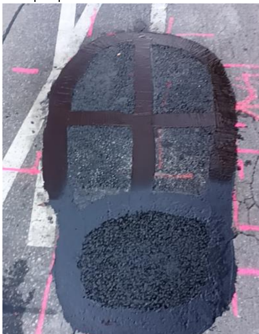
Foto po opravě
