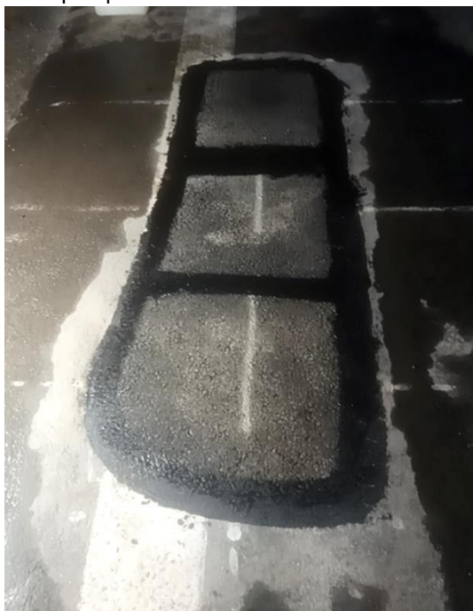
Foto po opravě
