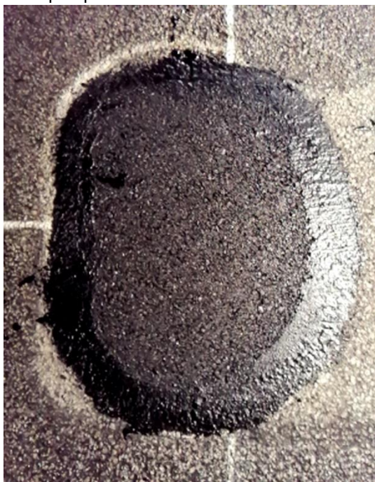
Foto po opravě
