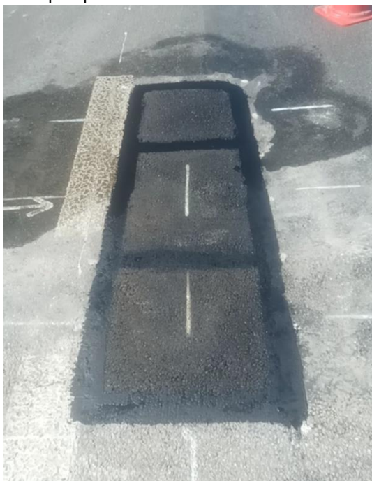
Foto po opravě
