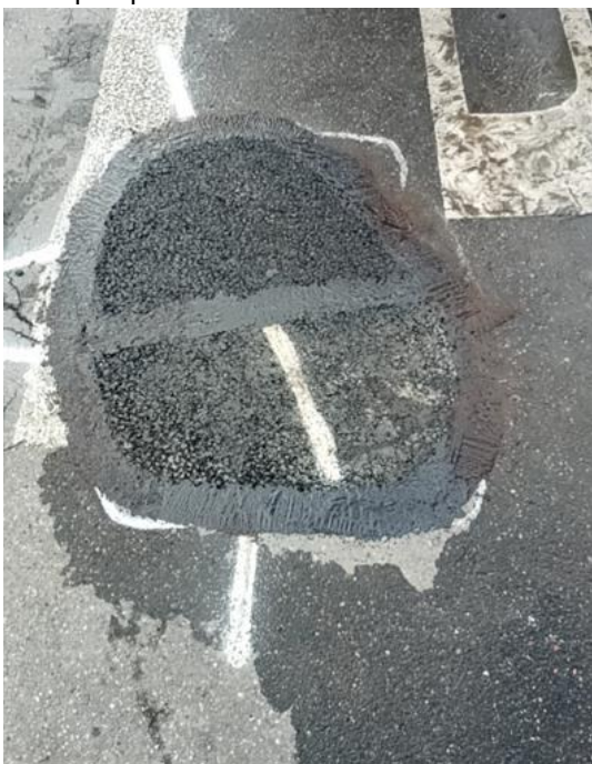
Foto po opravě
