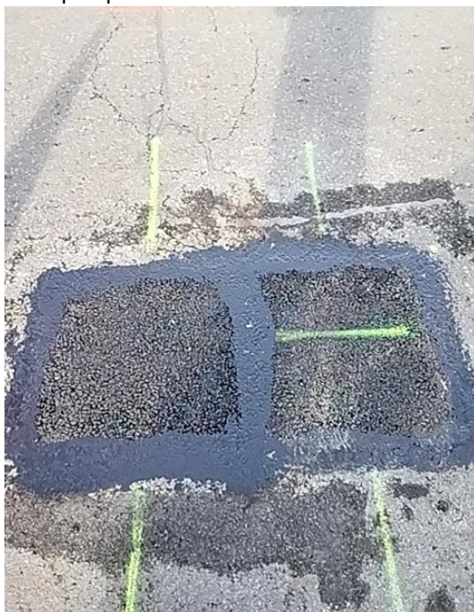
Foto po opravě
