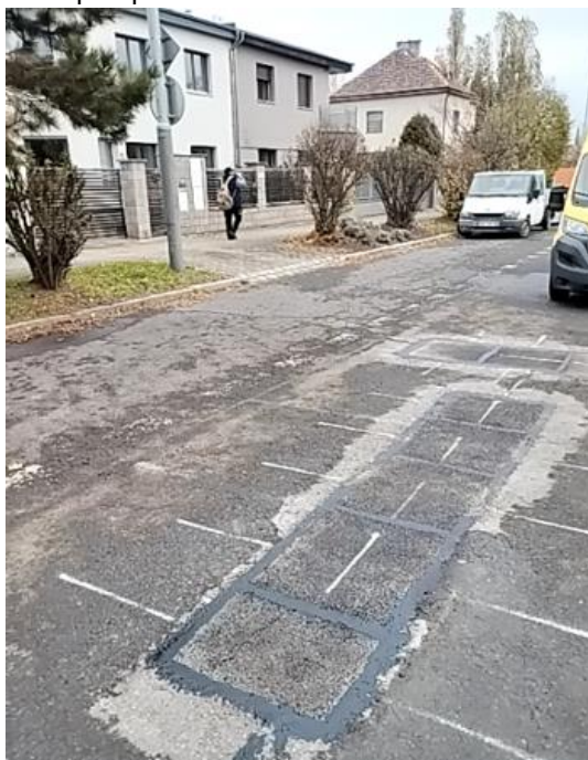
Foto po opravě
