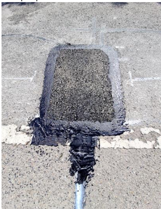
Foto po opravě
