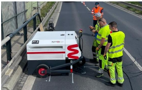
Oprava pomocí „mikrovlnného cestáře“ FT-3
