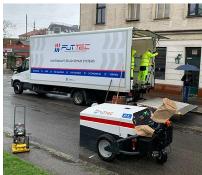
Opravy výtluků mikrovlnnou technologií FUTTEC® ve Vídni
